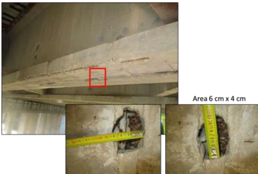
Figura 14: Estensione del difetto LOCALIZZATO
