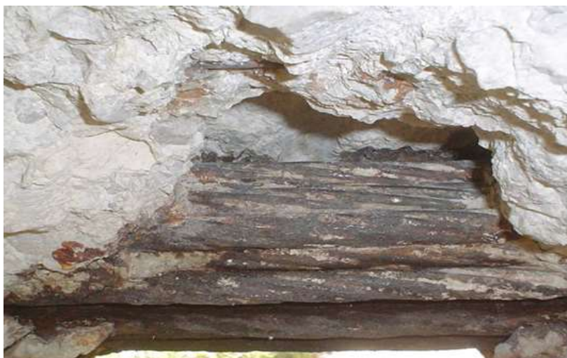
Figura 53 - Saggio per il rilievo del numero e del diametro dei trefoli
