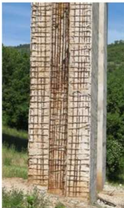
Figura 15: Estensione del difetto ESTESO
