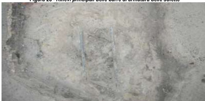
Figura 29 - Rilievo di barre di armatura dell'estradosso delle solette
