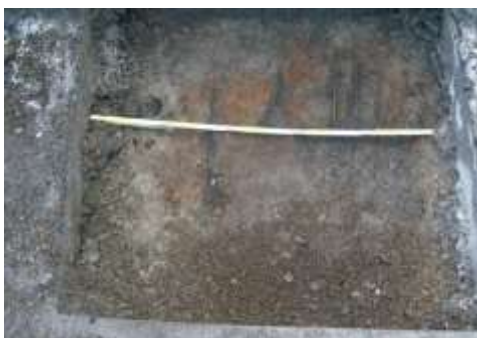
Figura 3 - Saggio in soletta
